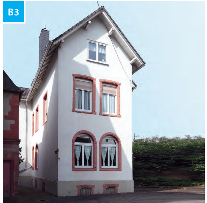
Putzfassade mit Fensterlaibungen aus Werkstein
