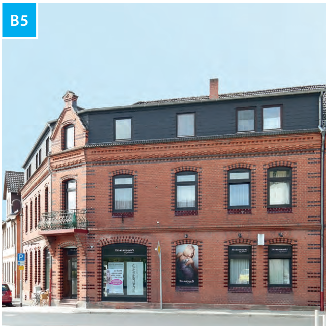
Sichtmauerwerk mit horizontalen Bändern aus Ziersteinen
